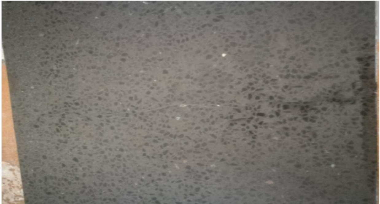
Foto opravené spáry v černém terase ihned po opravě
