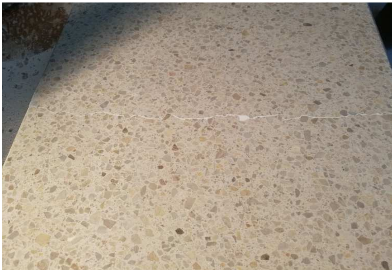
Foto opravené spáry v terase ihned po opravě – mokrý povrch
